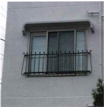
今回施工したサッシ周り
