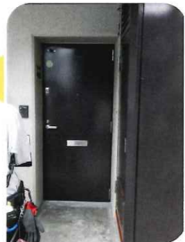
玄関ドア(交換前)
