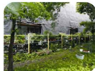
専有庭の足場・植栽仮置場
