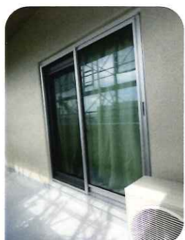
バルコニー側サッシ(交換後)
