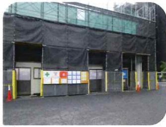
現場事務所・作業員詰所
