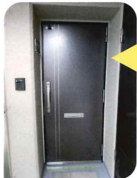
玄関ドア(交換後)
